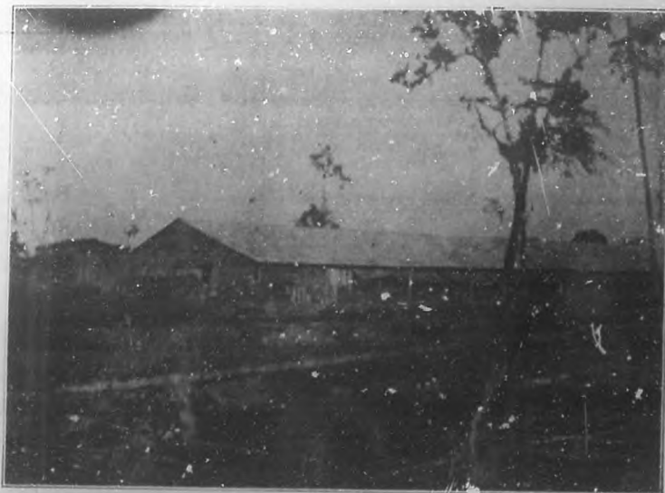
LA PROSPERIDAD DE NUESTROS CAMPOS.—Vista exterior del edificio principal que ocupa la fábrica de ladrillos de la sociedad Izquierdo y Compañía.
